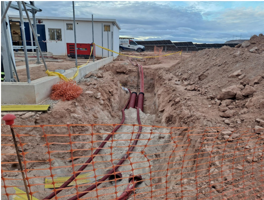
Foto 4. Zanjas para entubado línea de evacuación SET
