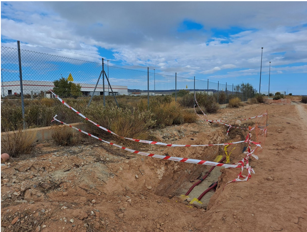
Foto 4. Zanjas para entubado línea de evacuación SET
